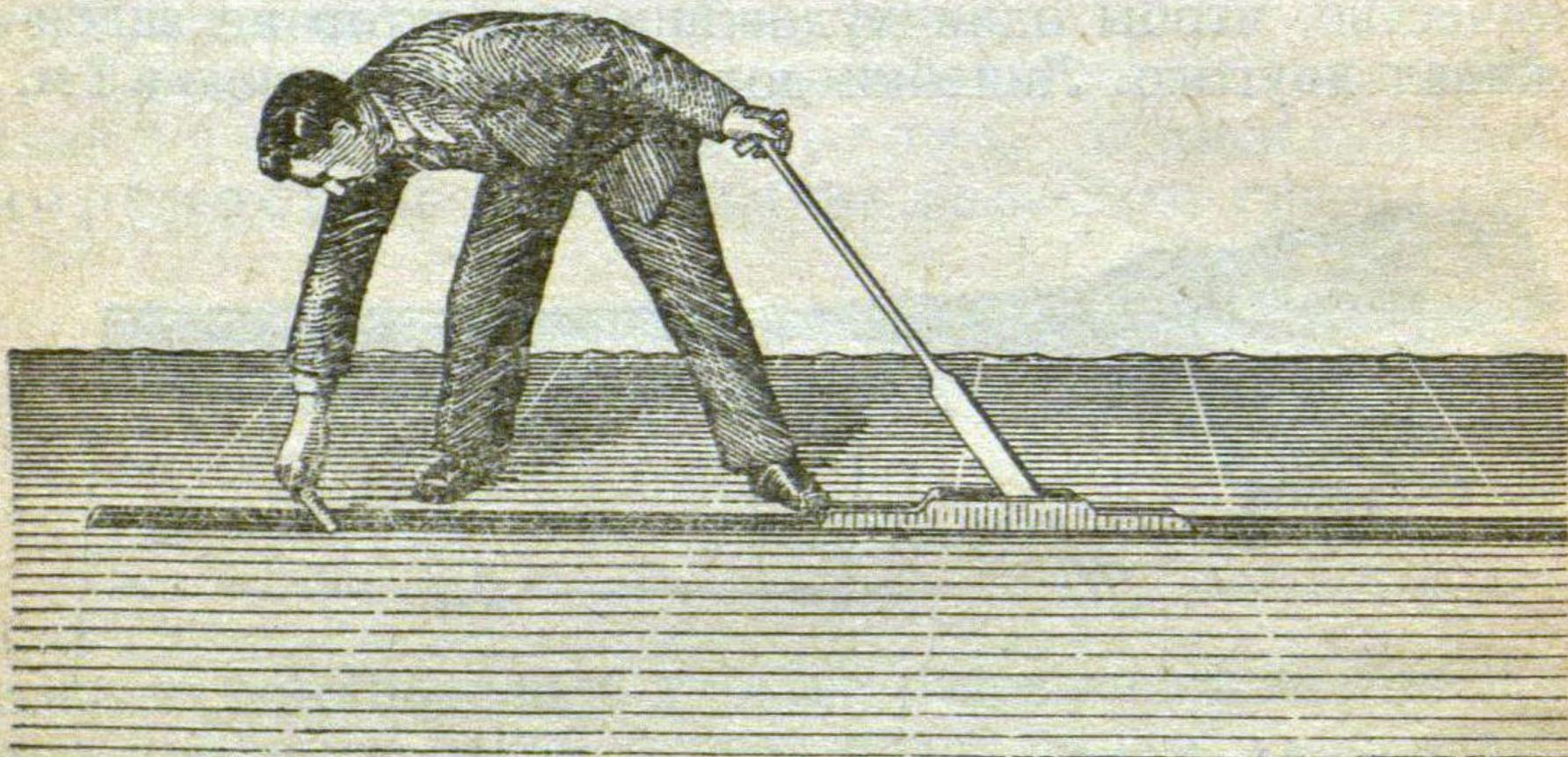
Р и с. 11. Расчерчивание по линейке
